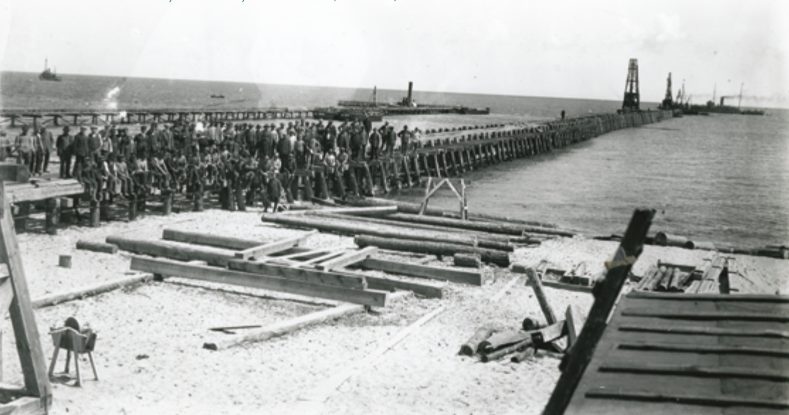
■ Port tymczasowy w budowie, 1922 r., MMG
