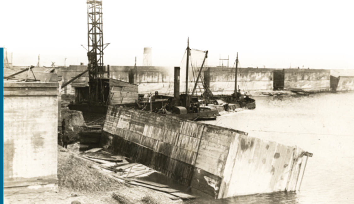
■ Skrzynie ze zbrojonego betonu podczas produkcji, ok. 1926 r., fot. Roman Morawski, MMG
