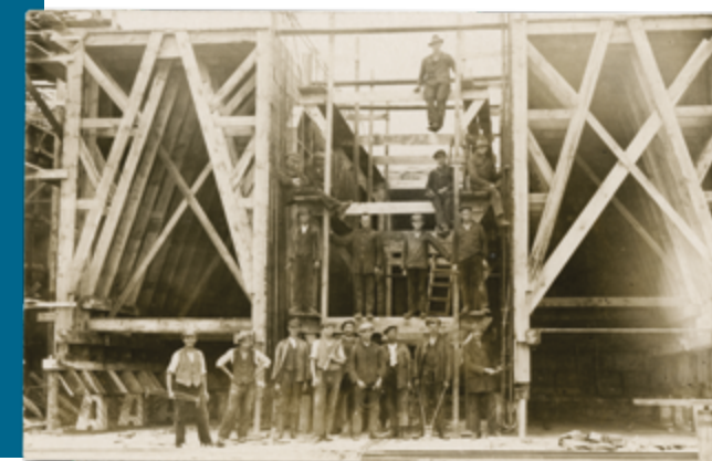
■ Robotnicy przy konstrukcji skrzyni, ok. 1926 r., fot. Roman Morawski, MMC
